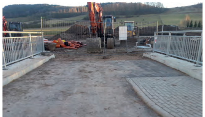
Zufahrt zum Kindergartenneubau
