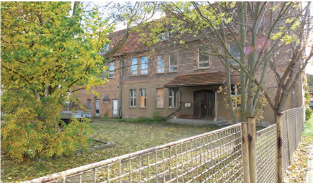
alte Grundschule- Bereich „Am Lämmerberg“
