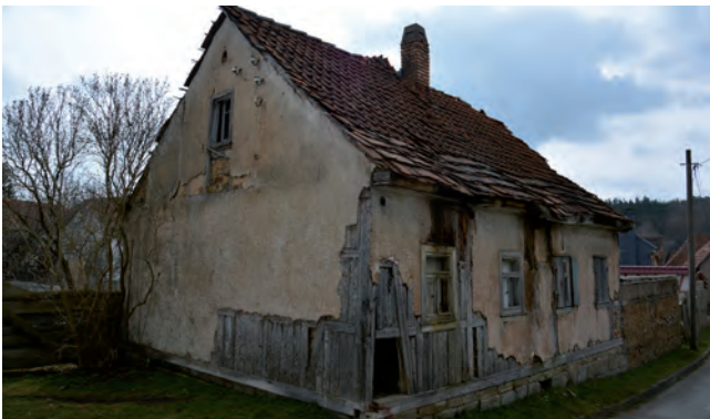
Hemmniss- leerstehende Gebäude/ Gebäuderuinen
