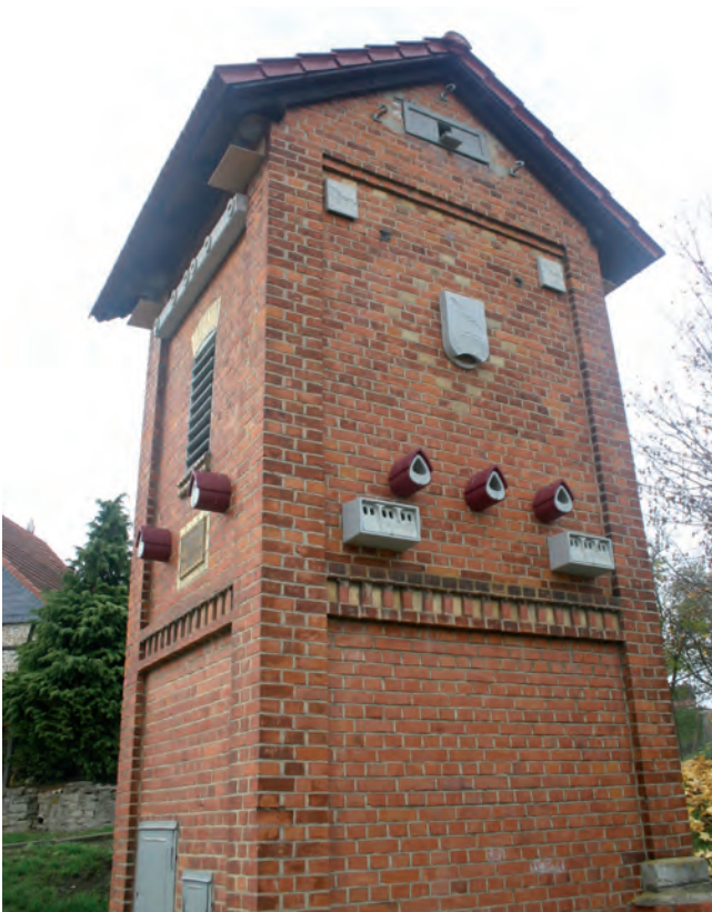
ehem. Transformatorenturm in Röhrensee
