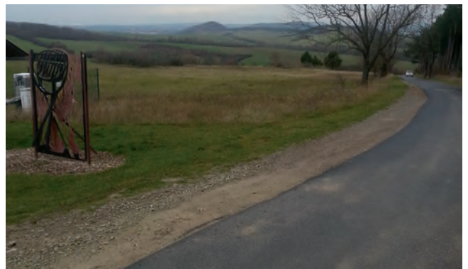
Fläche für Wanderparkplatz „Drei Gleichen Blick“ in Bittstädt
