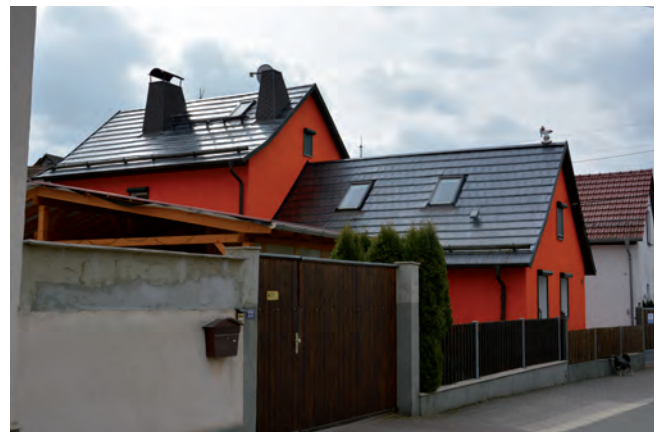
Verwendung von zu prägnanten Fassadenfarben und untypischen Dachziegel-farben für ein Dorf
