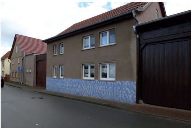
untypische Gestaltung des Gebäudesockels mit Fliesen
